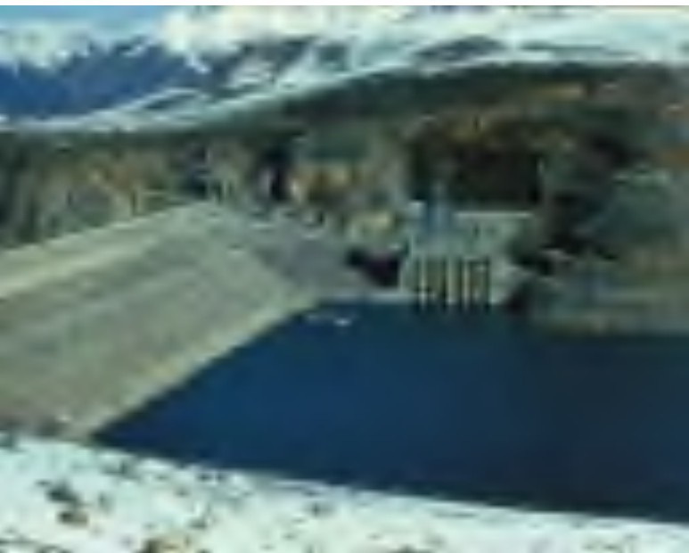
Chorvoq GESi (chapda suv ombori bilan yuqori bef - 2006 mln.m 3 , o'ngda - to'g'onga qaragan pastki bef, balandligi 168 m. va stansiya binosi)
